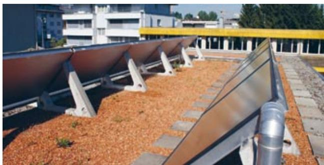
Solarmodule auf Betonaufständung angebaut. Gehwegplatten schützen das Abdichtungssystem bei Wartungs- und Unterhaltsarbeiten an den Modulen.
